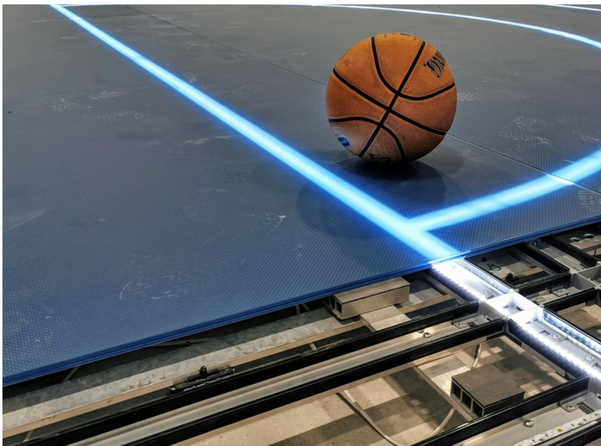
*Die Glasplatten sind mit Keramikpunkten auf der Oberfläche versehen, damit der Boden weniger rutschig wird und so die Reibungskoeffizienten der verschiedenen Sportnormen zu erfüllen.*
