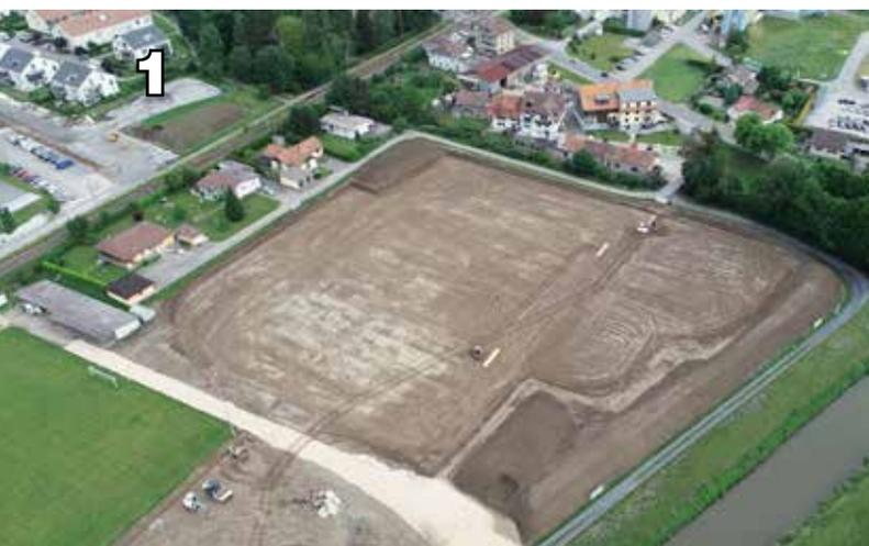
La prima fase della realizzazione di un campo da calcio in erba artificiale consiste nel creare una piattaforma le cui caratteristiche di planarità, portanza e stabilità nel tempo siano compatibili con tale progetto. La minima deformazione del sottosuolo sarà visibile in superficie e in alcuni casi può compromettere l'utilizzo stesso del campo.
