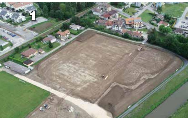
La première phase dans la réalisation d'un terrain de foot en gazon artificiel est de créer une plate-forme dont les caractéristiques de planéité, de portance et de stabilité dans le temps sont compatibles avec une telle réalisation. En effet, la moindre déformation du sous-sol sera visible en surface et peut dans certains cas mettre en cause l'utilisation même du terrain.
