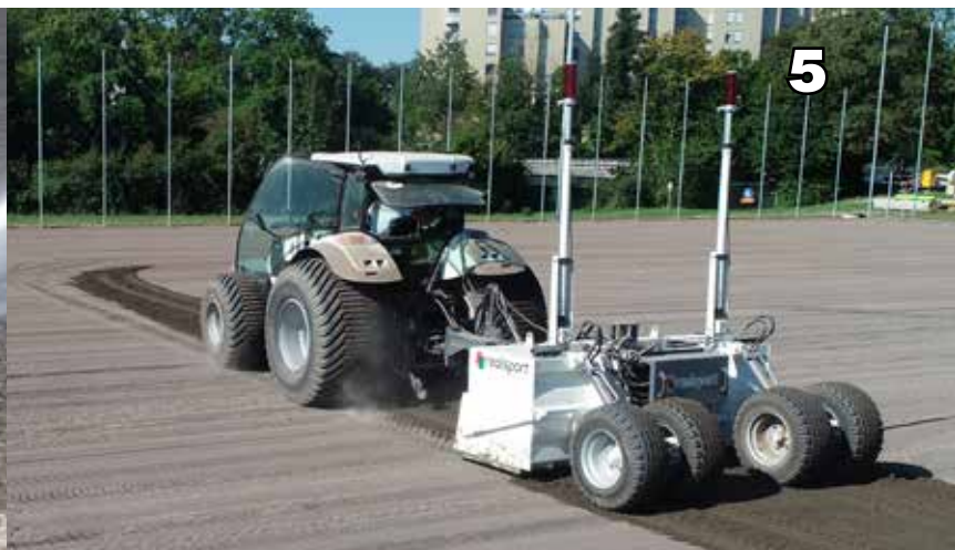
5 Réglage de la couche de support destinée à accueillir le gazon artificiel. Celle-ci peut être composée d'un enrobé bitumineux perméable ou de gravier dont la courbe permet une stabilité ainsi qu'une perméabilité indispensable au bon fonctionnement de la surface.
