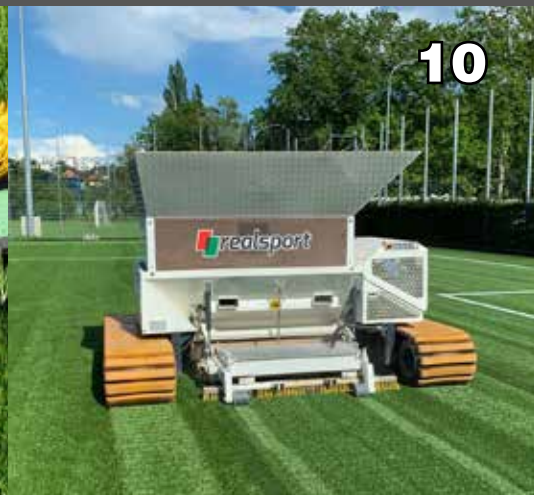
10 Remplissage de sable de quartz destiné à lester le tapis et de granulats de gomme pour en assurer les caractéristiques sportives.
