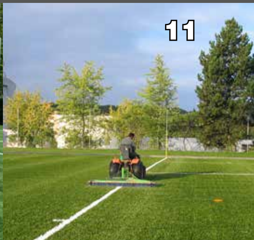
11 Brossage du gazon en phase de construction. Grâce à plusieurs cycles de brossage suivant un trajet prédéfini, les matériaux de remplissage sont répartis de façon régulière et en épaisseur constante.
