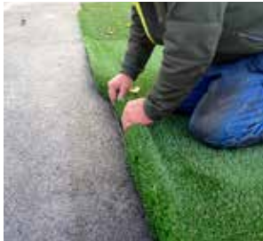
Le gazon synthétique est enfoncé dans l'élément d'installation.
