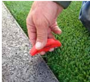
L'élément de fixation est tourné de 90 ° sur l'arrondi et la clé de montage est retirée.
