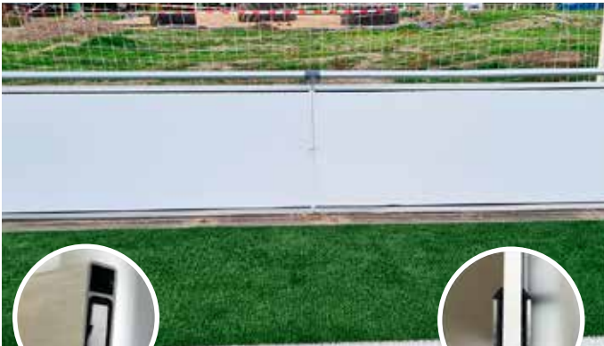
Illustration du rail supérieur avec joint en caoutchouc
