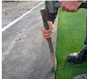
Pour les gazons synthétiques épais ou à poils longs, il est possible d'utiliser des outils tels que des fers à pointe.
