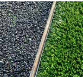
Revêtement / gazon artificiel (Dans le but d'augmenter la surface de revêtement, une bande métallique (acier plat) a été utilisée ici).
