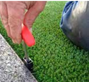
L'élément de fixation est inséré dans l'élément de montage à l'aide d'une clé de montage, jusqu'à la nervure inférieure (voir les photos des pages précédentes).
