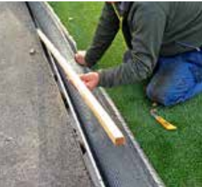
Retirer les éléments d'écartement (sont éliminés par le maître d'ouvrage).
