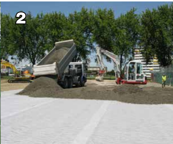
2 Mise en place d'un coffre de fondation permettant de transmettre les charges au sous-sol sans déformation.
