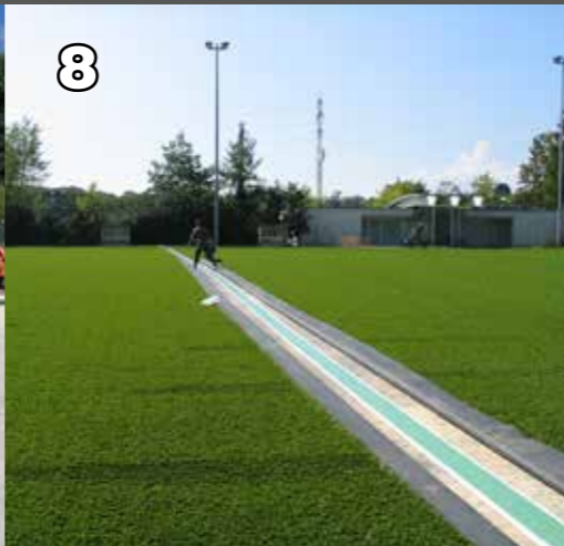
8 Les tapis sont posés côte à côte et collés avec une précision millimétrique.
