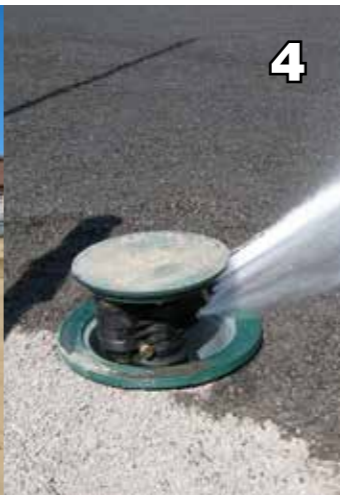
4 Test du système d'arrosage avant la pose de la couche de support. L'arrosage permet de gérer la température du revêtement lors de fortes chaleurs.
