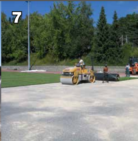
7 Les tapis sont déroulés et posés à même la couche de support, ou sur la couche de souplesse.
